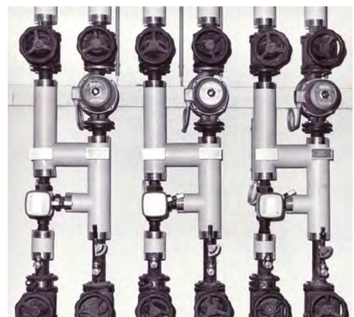
FAQ 24 Figure 2: Distributeur à injection avec robinets à 3 voies
